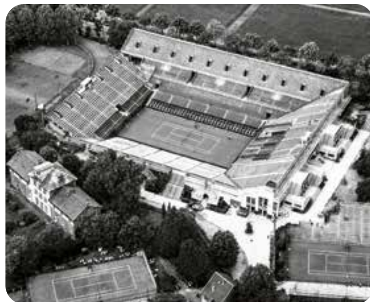
Le stade Roland-Garros au début des années 1970 avec, en bas à gauche du court central, l'Institut Marey qui laissera place au court n°1, inauguré en 1980 et démolé en 2019.
